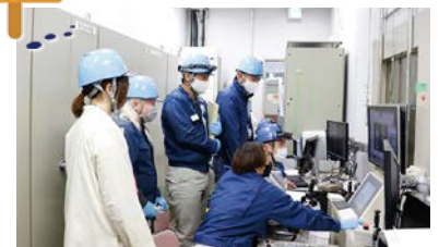
ターゲットステーション操作室からのクレーン運転
